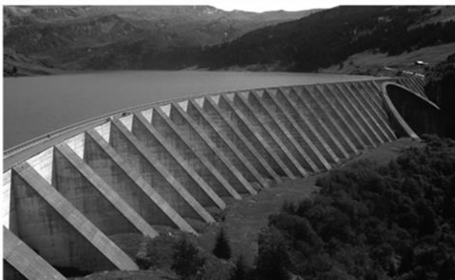
شکل ۱۲-۴: سد Roselend در فرانسه با ویژگی‌های قوسی و پایه‌دار که برای نیروگاه آبی ساخته شده است.
