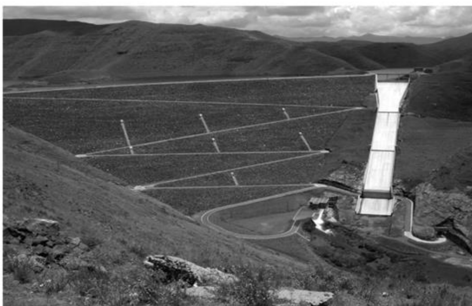
شکل ۱۲-۲ دیوار خاکی سد Mohale , بخش مهمی از ارتفاعات لسوتو — Water Scheme (©David Love / CC 0)
